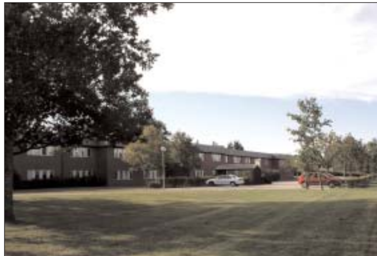
Avdelning 3 och 4 är först ut i ombyggnadsarbetena.
