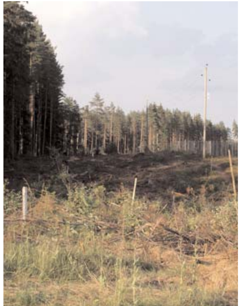
Förberedelserna för att dra fram rörledningarna från Bergaåsen utanför Ljungby till Alvesta och Växjö är i full gång. Här har skogen avverkat längs med väg 25 i Forssa väster om Alvesta.
